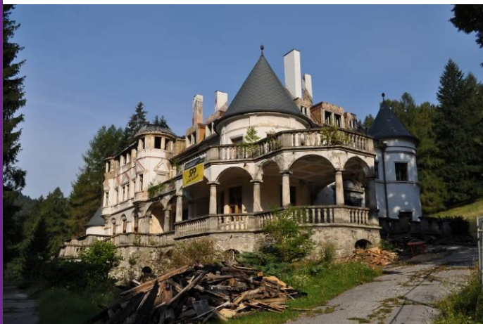
Stav po požiarí v r. 2010
