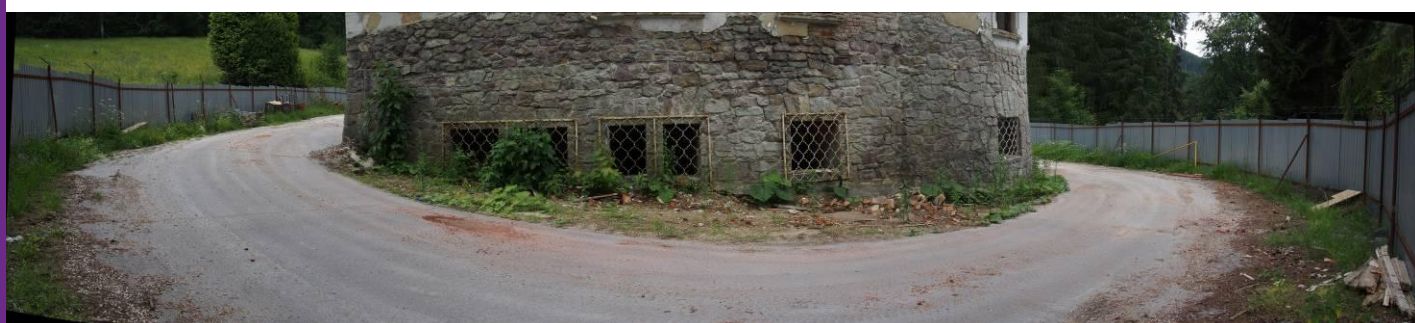
Terén pred západnou fasádou
